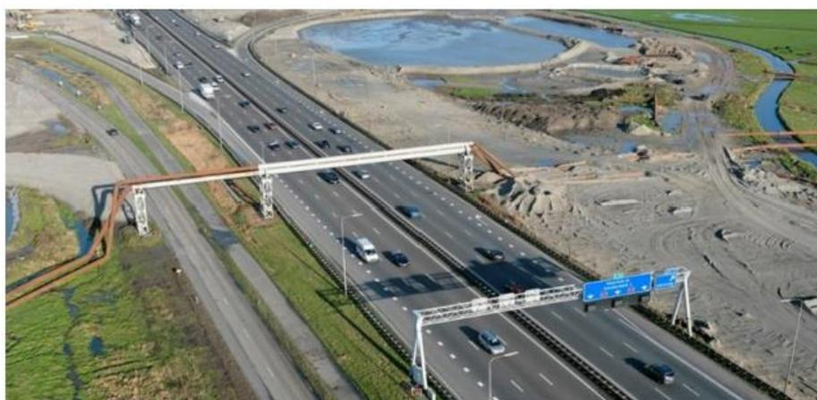
*Exemple de traversée de route par pont tubulaire avec caisson (source : Eastman)*
